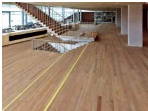
Vloeren van zwaarder hout dragen beperkt bij aan brand. Cumaru ( 1.050 \text{ kg/m}^3 ) in Muziekgebouw aan 't IJ Amsterdam; ontwerp: 3x Nielsen Århus, Denemarken.
