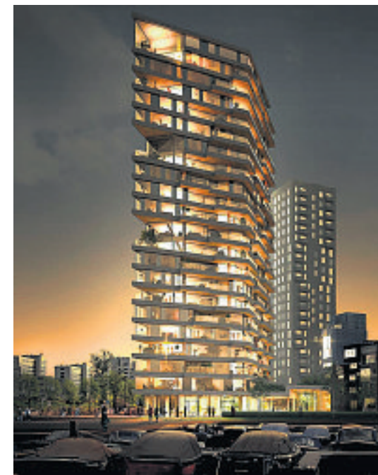
In Amsterdam verrijst bij de Amstel de woontoren Haut. Het gebouw wordt 73 meter hoog en heeft een betonnen kern.
